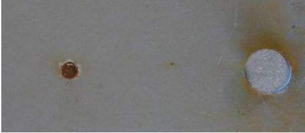
図 C-2 ウェーブタンク試験の底板試験片における人工塗膜欠落からの剥離 (このモデル報告書の結果例は写真例と関係ない)
