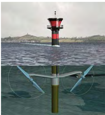
図10 2008年から北アイルランド ストランフォード湾で発電中の1.2MW 潮流発電設備 SeaGen（現在はシーメンス）
