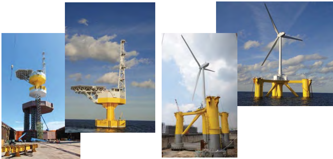
浮体式洋上変電設備 「ふくしま絆」
