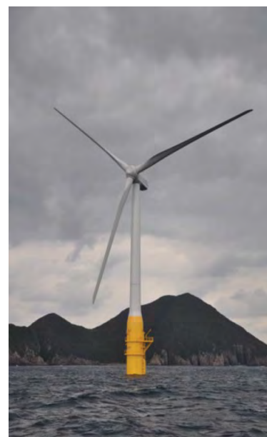
2013年10月に設置された2MW実証機「はえんかぜ」
