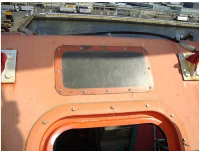
창문을 통한 가시성이 떨어진 상태
