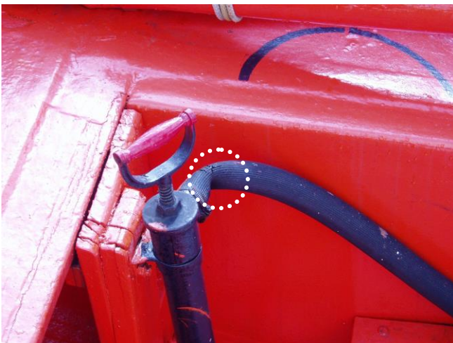
빌지 펌프의 찢어진 호스
