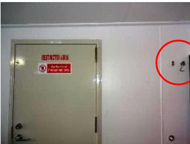
(자동 닫힘식) 도어에 불필요한 홀드백 후크가 설치된 상태!
