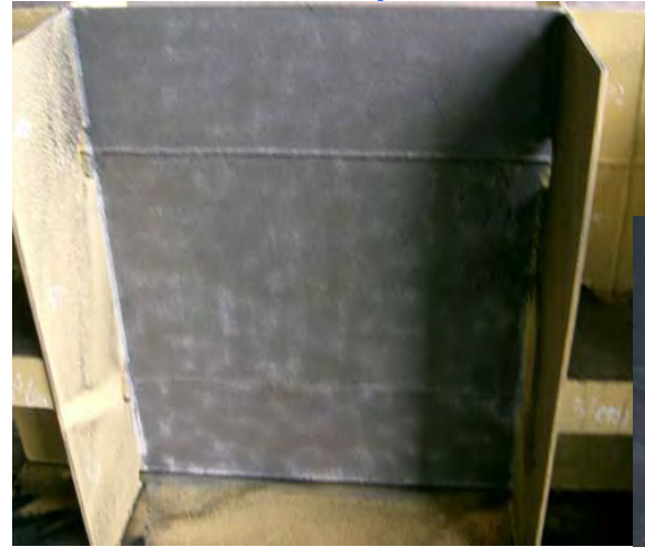
混気ジェットによる 剥離後
