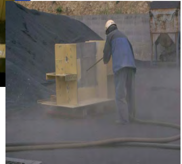
ドライブラストによる 剥離作業
