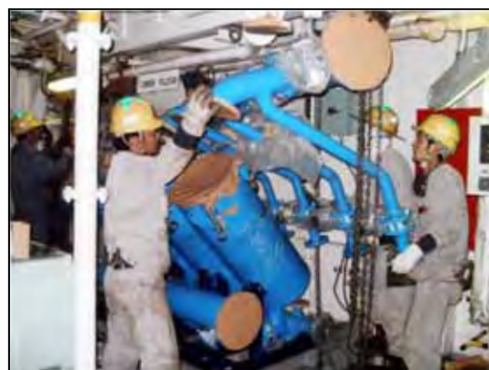
機器搬入設置
