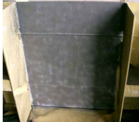
混気ジェットによる 剥離後
