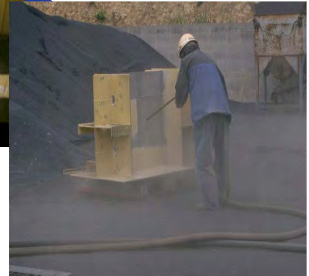
ドライブラストによる 剥離作業
