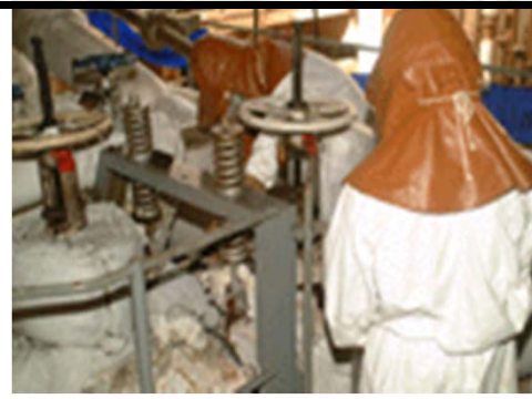
正在拆解石棉 (Dismantling asbestos)
