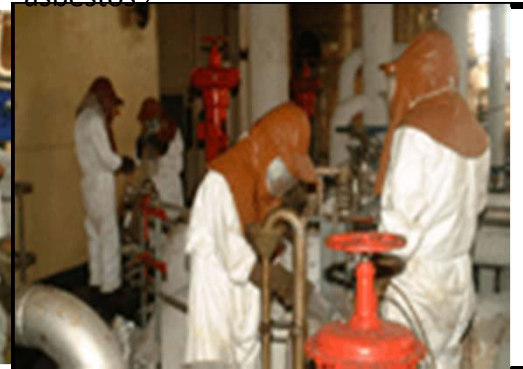
正在拆解石棉 (Dismantling asbestos)
