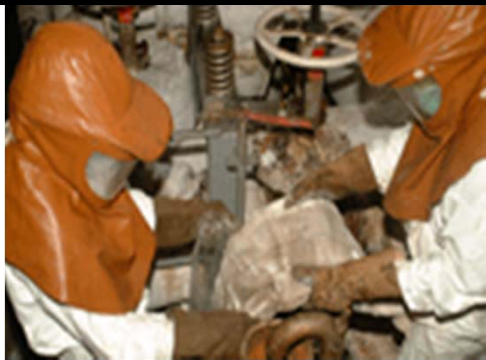
正在拆解石棉 (Dismantling asbestos)
