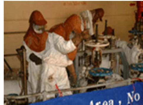
正在拆解石棉 (Dismantling asbestos)
