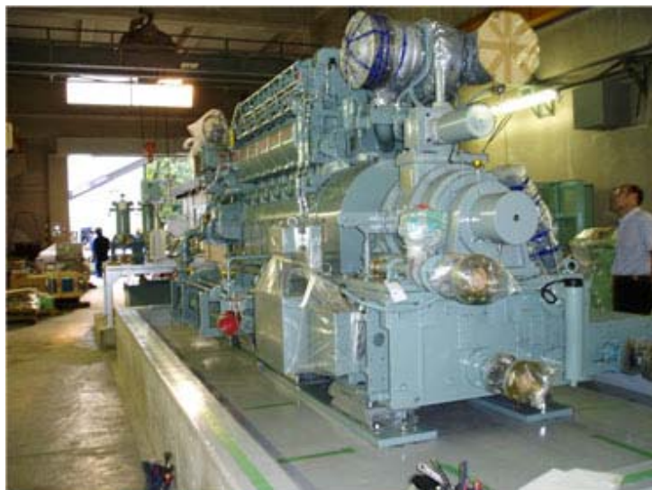
供試機関の外観
