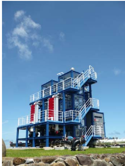
沖縄県 海洋温度差発電実証設備
