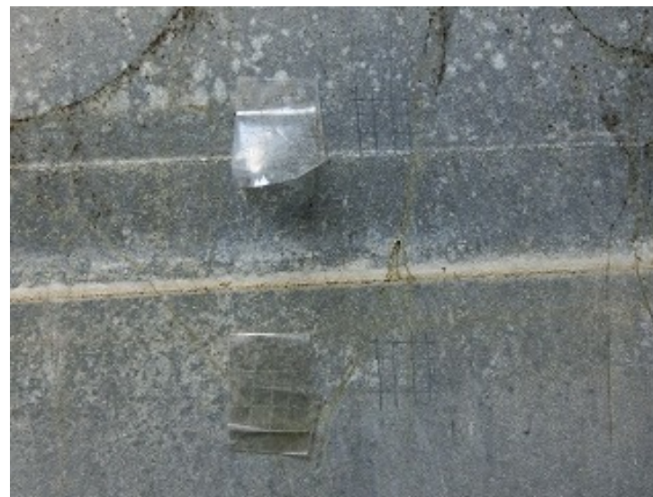
腐食していない水際部の付着性は良好
