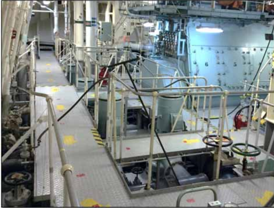
敷板取外し前
