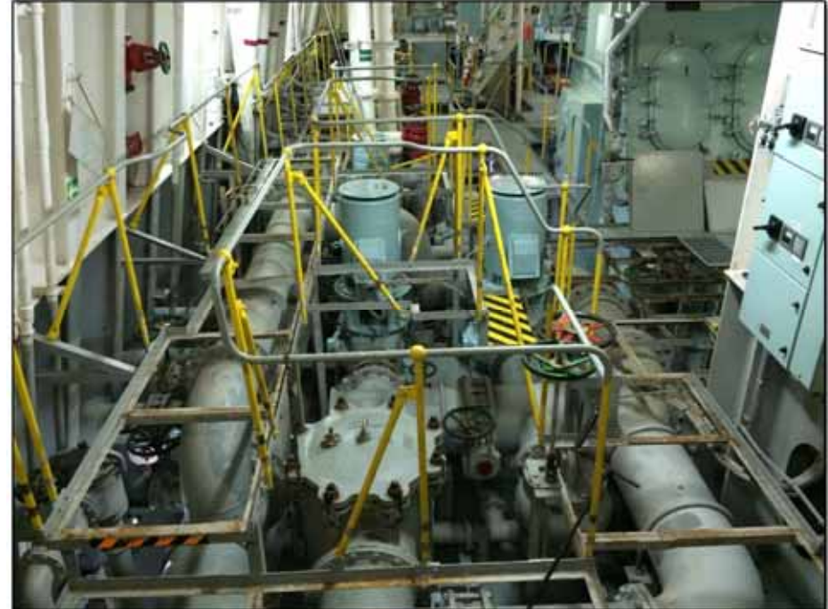
敷板取外し後
