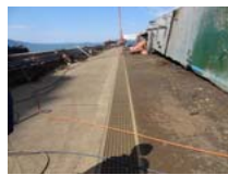
解体場内の排水溝
