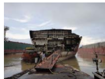
岸壁における解体 (中国)
