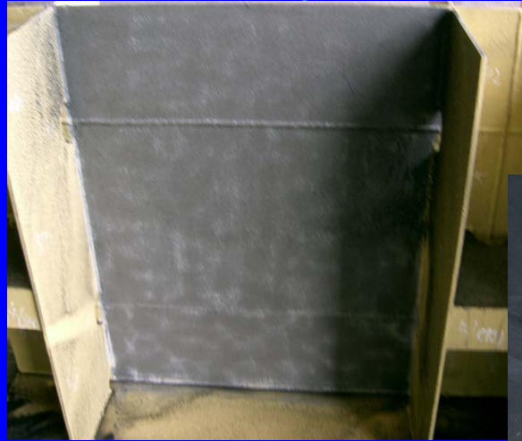
混気ジェットによる 剥離後
