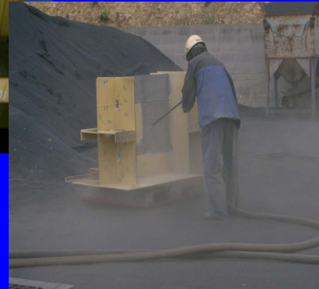
ドライブラストによる 剥離作業
