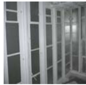
図 2.3.9 鋼壁への施工例 2
