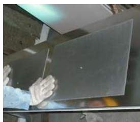
図 2.3.12 制振材をビス止め
