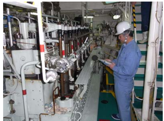
図3 機関室での騒音測定
