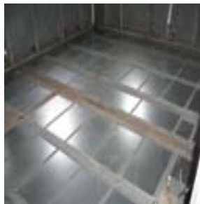
図 2.3.16 制振材貼り付け後の床
