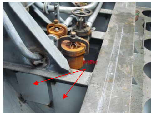
図 2.3.23 主機台横隔壁への貼り付け
