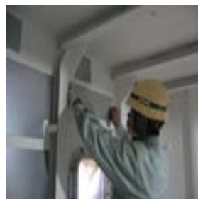
図 2.3.3 制振材の貼り付け
