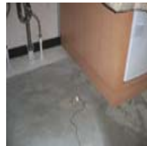
図 2.3.17 デッキコンポジション施工
