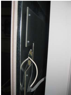
図 2.3.13 制振材のカット部分 (電線取り出し口)
