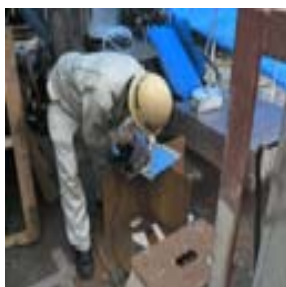
図 2.3.2 制振材の切断
