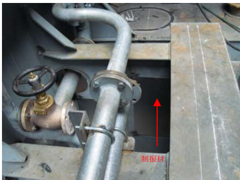
図 2.3.22 主機台横隔壁への貼り付け
