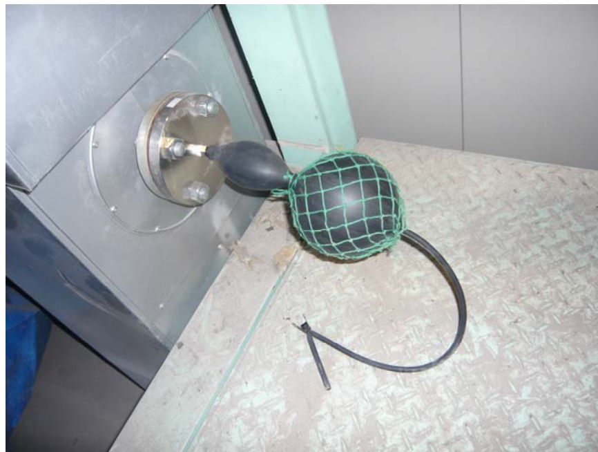
写真3.2.7.6 2連球による臭気計測状況
