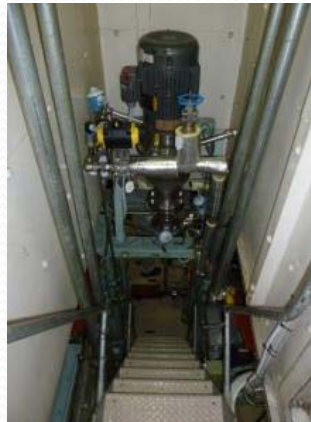
タービン-発電機
