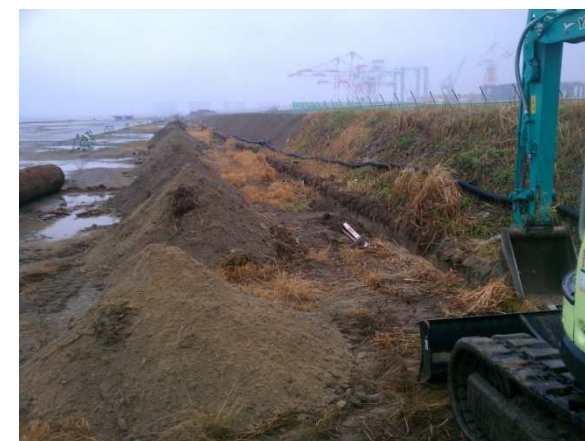
配線埋設工事状況
