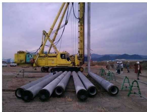
杭打工事状況
