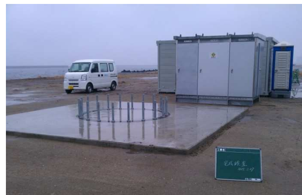
完成した基礎
