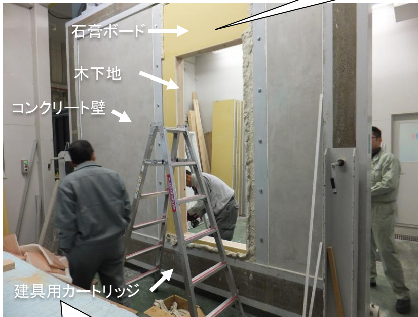
試験体 扉単体 施工状況
