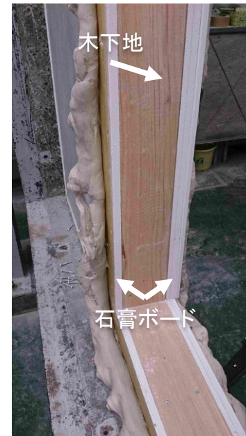
完成した仮想壁内面
