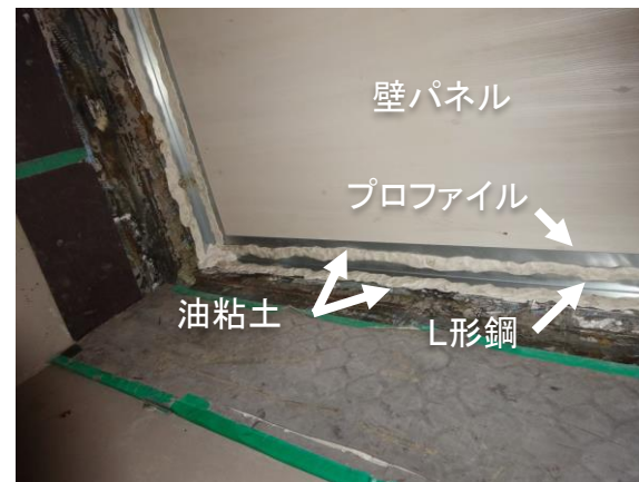
試験体 隙間処理状況
