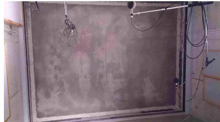
試験室内設置状況
