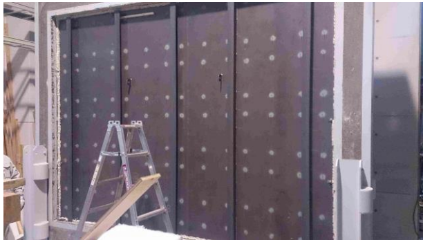
試験体 防熱ピン施工状況
