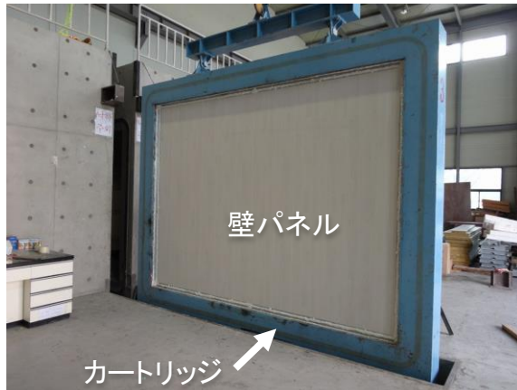
試験体カートリッジ取付状況
