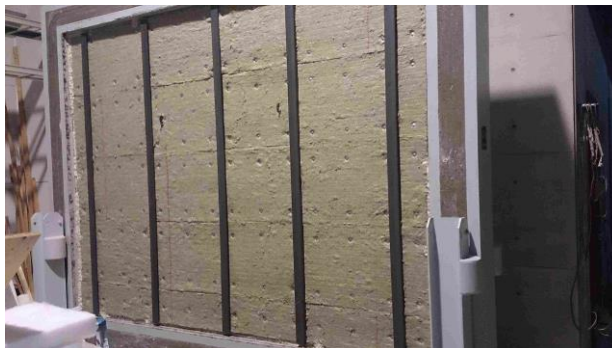
試験体 ロックウール施工状況
