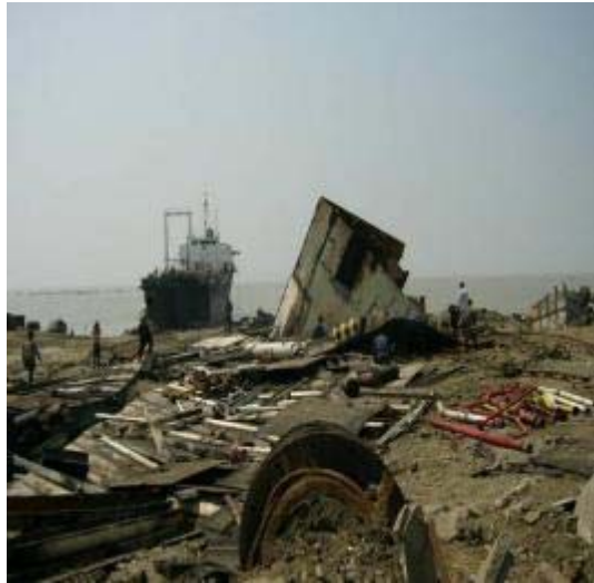
バングラディッシュの解体ヤード
