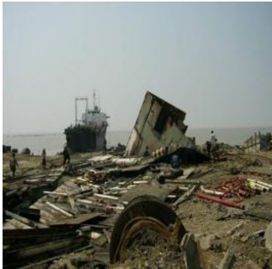
未整備の解体ヤード
