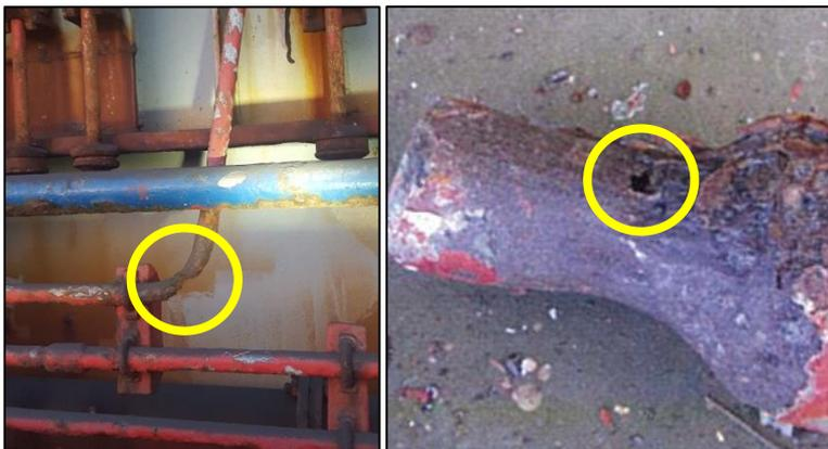
腐食破口した CO<sub>2</sub> 管
