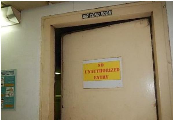
自動閉鎖装置の作動不良
