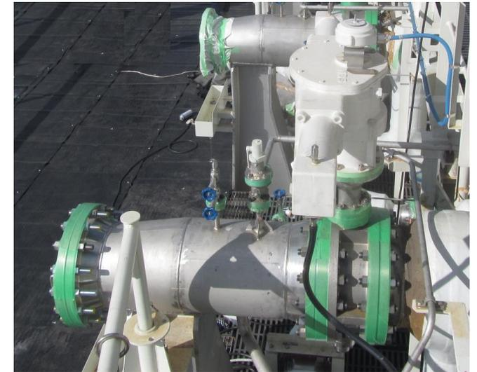
緊急遮断弁の一例
